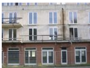
Bauruine am Bahnhof-Altenessen
