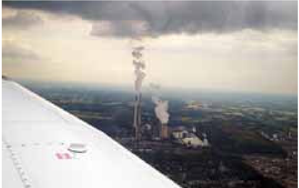
Das Steag-Heizkraftwerk Herne verfügt über drei Blöcke, in denen aus Steinkohle Strom, und Fernwärme für die die Fernwärmeschiene Ruhr erzeugt wird. Foto Verena Segert
